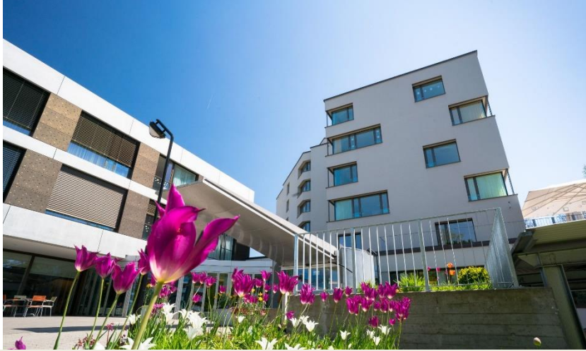
Erfahrungsbericht Alterswohnheim Am Wildbach
